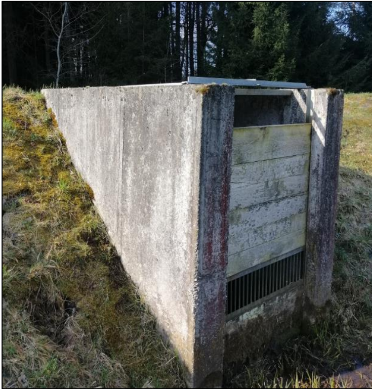
Abbildung 6: Auslaufbauwerk des RRB2
